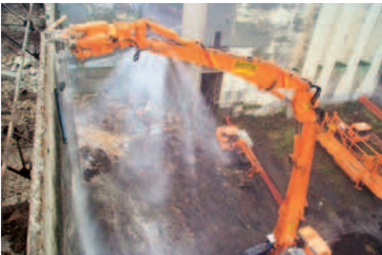
Das RAM-ED-System ist am Baggerausleger montiert und sorgt beim Abbruch mit der Zange wie auch beim Schneiden auf dem Recyclingplatz für staubfreies Arbeiten.
