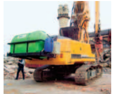
Mit einem am Baggerheck angebrachten Wassertank lässt sich bis zu acht Stunden lang autark arbeiten. (Fotos: RAM)
